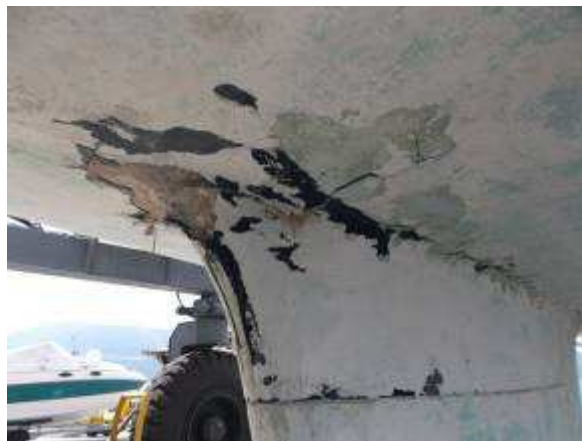
Slika 42. Oštećenje spoja i delaminacija materijala. 87
