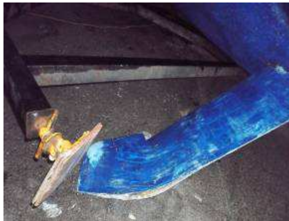
Slika 44. Delaminacija i oštećenje lista kormila. 89
