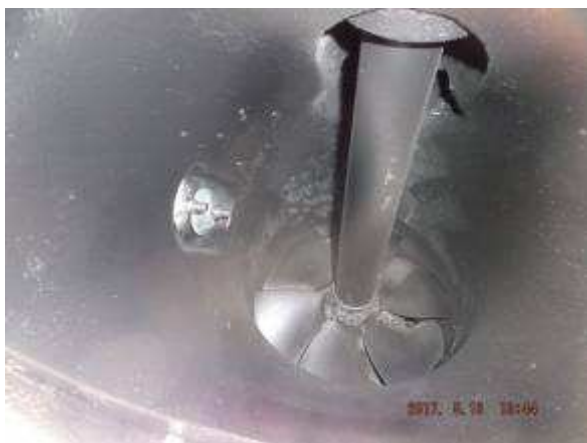
Slika 37. Očišćen usisni tunel i zamijenjene zaštitne anode. 82
