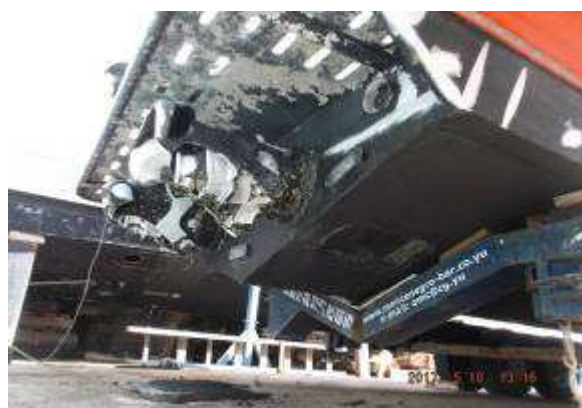
Slika 36. Sanirana djelimična oštećenja. 81
