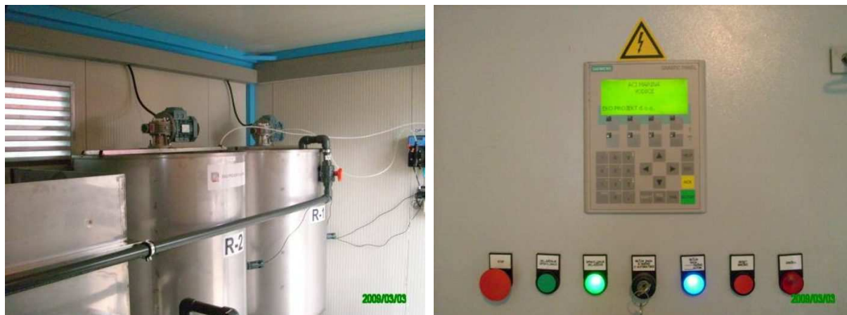
Slika 6. Postrojenja za prečišćavanje vode u marini Vodice
